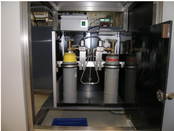
Bild 3 Sicherheitsschrank für 2 Stahlflaschen ( \text{SO}_2 )
